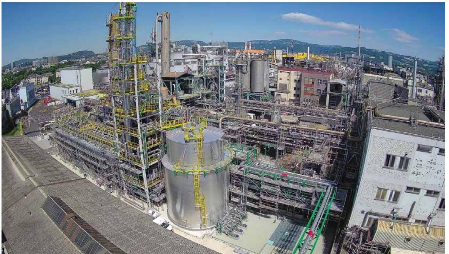
zwei bestehende thermische Abwasseraufbereitungsanlagen. Eine neue Abwasseraufbereitungsanlage mit einem 1.000 Kubikmeter großen Doppelmanteltank
