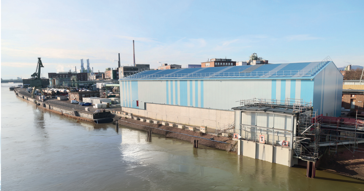
Das neue Flusswasserwerk versorgt den Industriepark Höchst mit 15.000 Kubikmeter Wasser pro Stunde.
