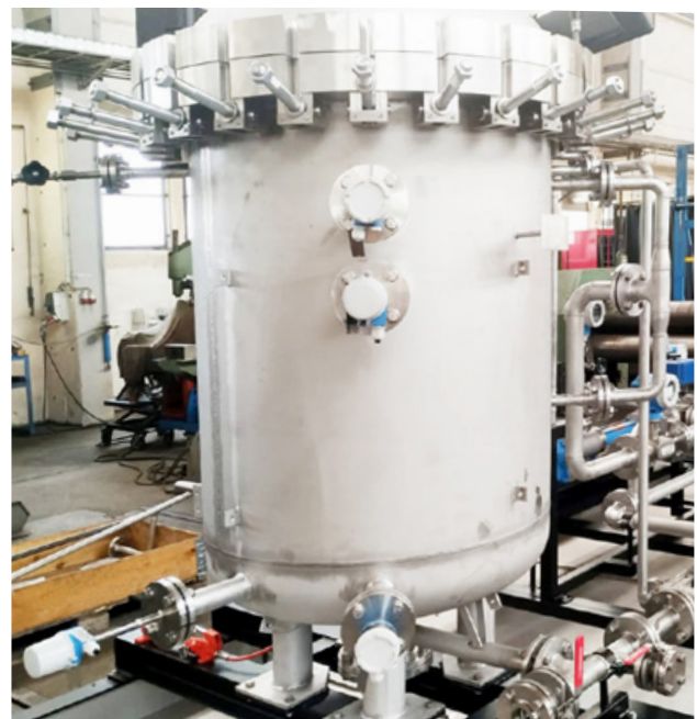
Abb. 1: LEPD-Pilotanlage der EDL in Leipzig während der Montage
