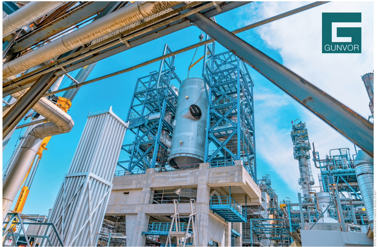
Einheben des Kolonnenunterteils - Durchmesser 5,8 Meter, Länge 19,1 Meter, Gewicht 52 Tonnen - auf das Fundament.
