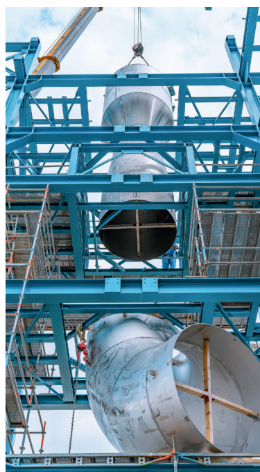
Einheben des Kolonnenunterteils - Durchmesser 5,8 Meter, Länge 19,1 Meter, Gewicht 52 Tonnen - auf das Fundament.
